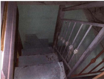
Foto 8 – Vista della scala metallica a servizio del soppalco in legno
