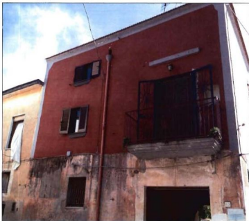
Foto 1 – Prospetto su via Acquarossa (già via Nuova Lavorate)
