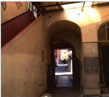
Foto 2 – Vista dal cortile dell'androne di ingresso
